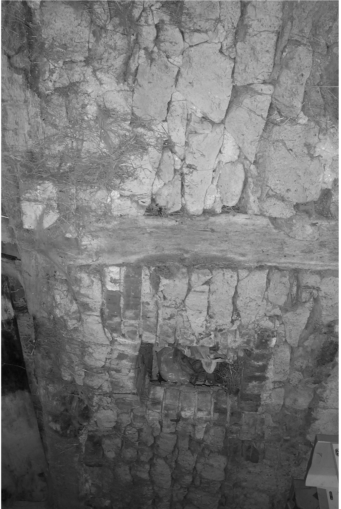
Ro(u)ssillon-Scheune auf dem Weibweiler Hof - Scheunenwand Zustand: Januar 2003
