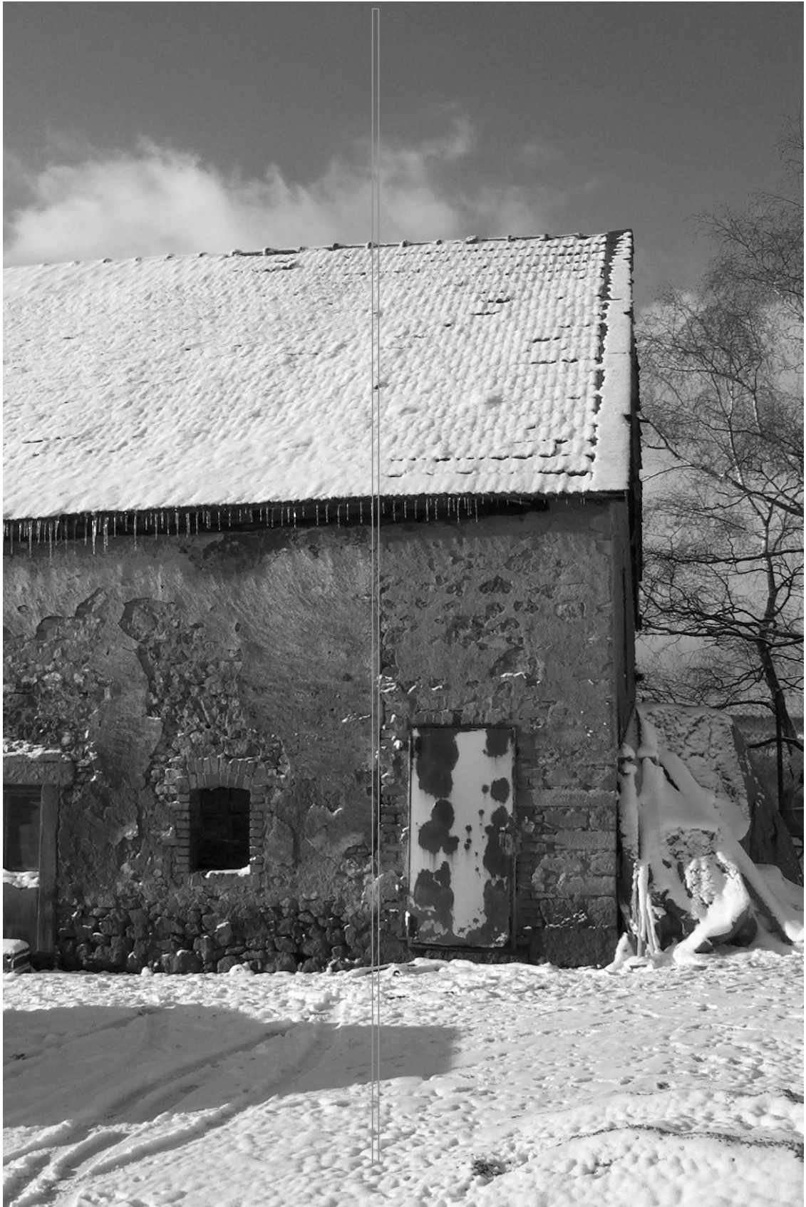
Ro(u)ssillon-Scheune auf dem Weibweiler Hof Zustand: Januar 2003 Links: alte Ro(u)ssillon-Scheune aus Bruchsteinmauerwerk Rechts: Anbau aus behauen Quadersteinen
